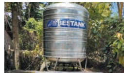
貯水タンクの設置 雨水を貯めて管理・給水するタンクを設置
