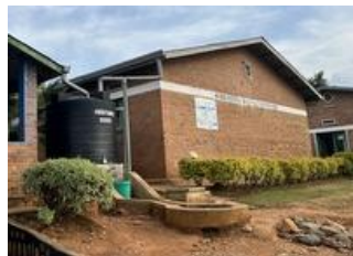
学校や医療施設に給水システムを設置します
