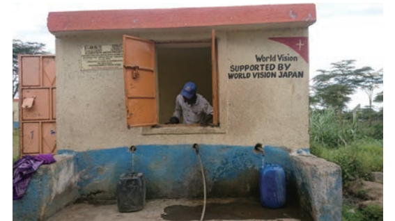
水キオスク。乾期には水を汲む人たちが 1km 以上の列ができます。貴重な水を地域全体で有効に活用するため、安価で水を販売する水キオスクの設置を進めています
