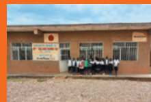
小学校に建設された新しい教室
