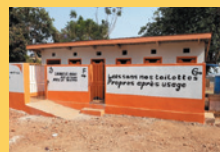
新しく建設されたトイレには、プライバシーを守るためのドアと障害者用のスロープがついています
