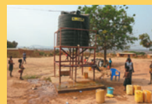
コミュニティ内に設置された給水施設
