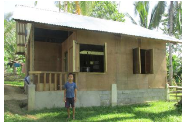
台風で壊れた家の修復の支援も行っています
