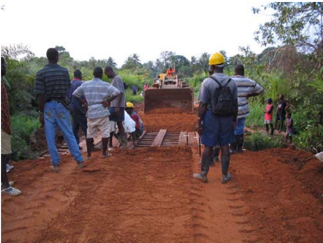
2.3.2 重機の力を借りて、橋の両側に土を盛り上げ打ち固めた模様(テウォー県 Jenneh Wonde - Kongo 間)
