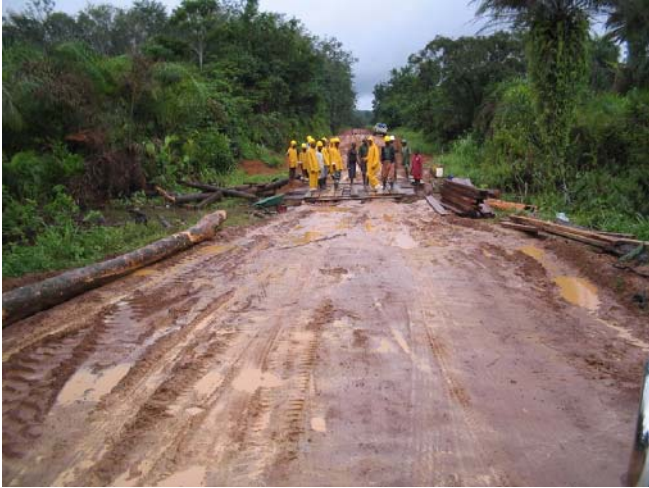
2.2 橋修復作業(テウォー県 Mambo Creek)
