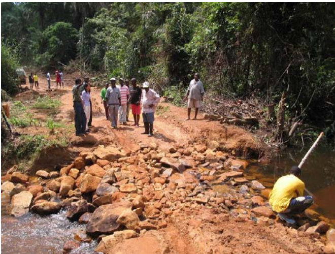
1.1 修復前は、丸太や写真のように石を敷き、一時的な手当をコミュニティが行なってきた(ポパ県 Magima Creek#1)
