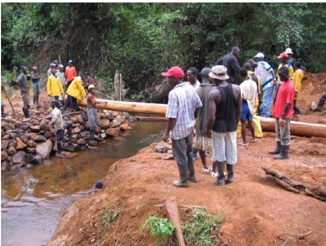
2.1 石を除き、丸太をかけ橋を修復している模様(ポパ県 Magima Creek #1)
