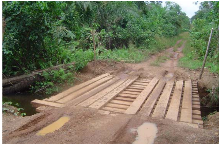
2.4 完成したハジラ橋の様相(ポパ県ハジラ)
