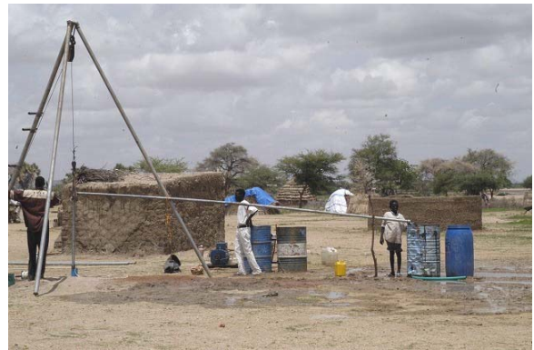
写真4・5：揚水試験中
