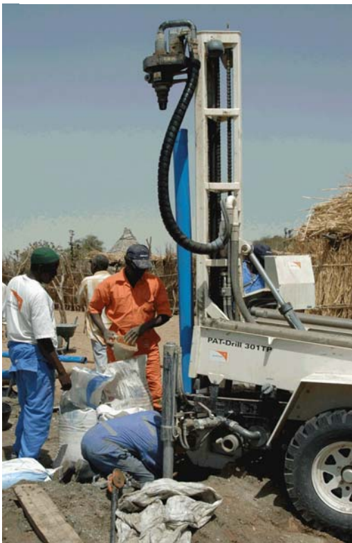
写真3：フィルター(豆砂利)充填
