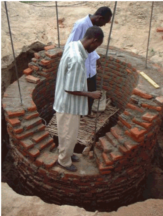
写真3：井戸壁構築中。基礎は鉄筋コンクリートでできている。
