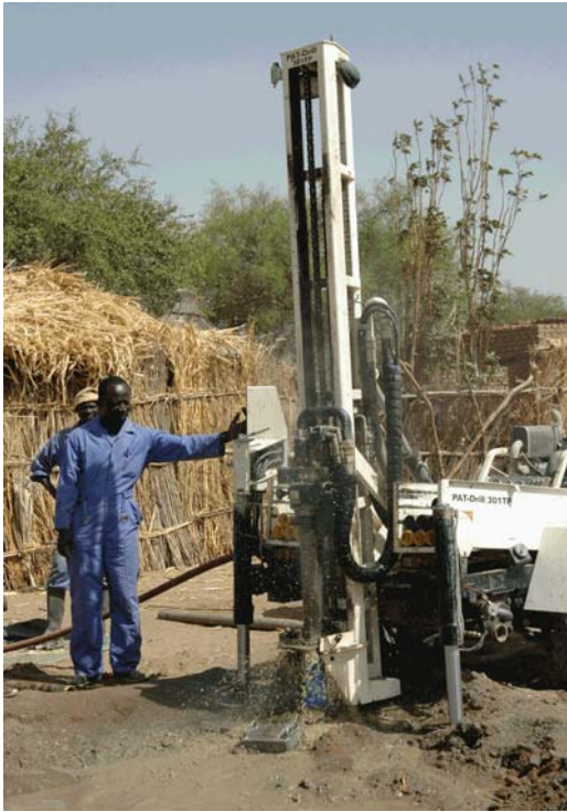
写真1：井戸孔掘削中
