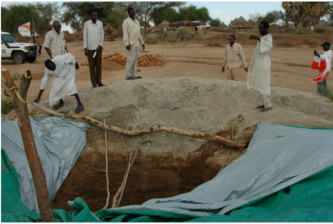
写真1・2：井戸掘削中。地下水が出てきたところ。
