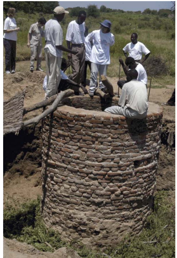
写真4：井戸壁完成。スタッフと打ち合わせ中。
