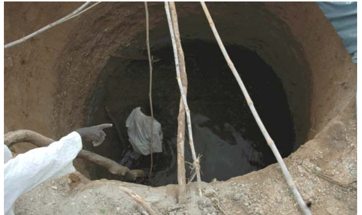
写真1・2：井戸掘削中。地下水が出てきたところ。
