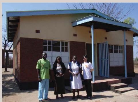
完成したセンザニHIVセンター（右はワールド・ビジョン・ジャパン中村スタッフ）
